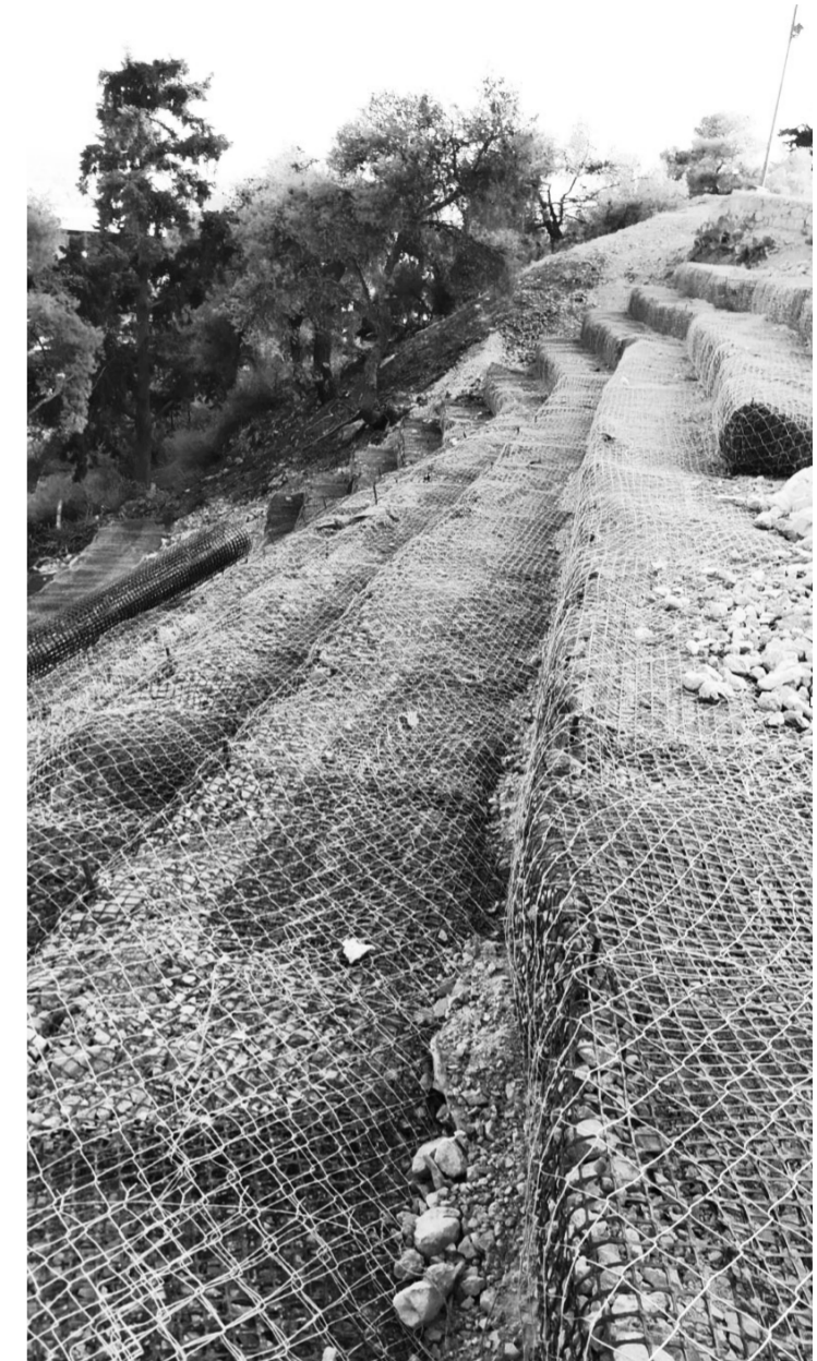
Φωτογραφία απ' το Λυκαβηττό όπου βλέπουμε τον τρόπο συγκράτησης των πρανών με χρήση γεωπλεγμάτων και συρματοκιβωτίων. (01.08.2022)
